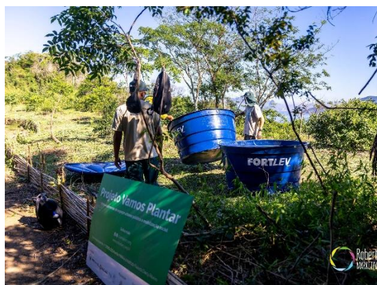
Figura 6-18 Instalação de caixas d'água para a implantação de sistema manual de irrigação junto ao plantio. Fonte: Carpe, 2025.
