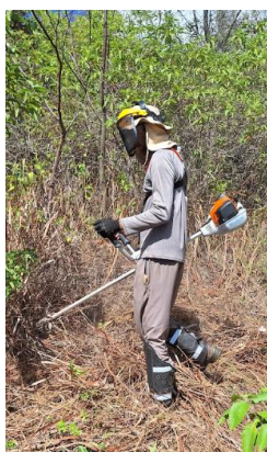
Figura 6-5 Colaborador realizando a limpeza semimecanizada da área de plantio. Fonte: Carpe, 2025.
