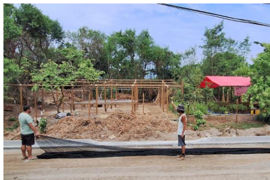
Figura 6-2 Colaboradores realizando a instalação de sombrite. Fonte: Carpe, 2025.
