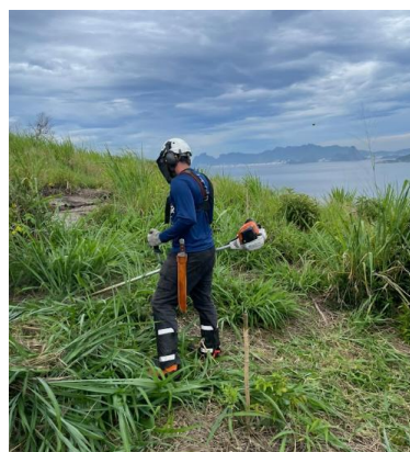
Figura 6-6 Colaborador realizando a limpeza semimecanizada da área de plantio. Fonte: Carpe, 2025.
