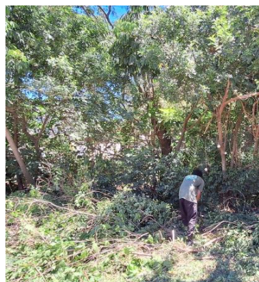
Figura 6-22 Poda de árvores preexistentes e limpeza da área de plantio. Fonte: Carpe, 2025.
