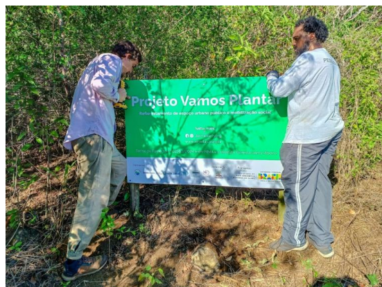
Figura 6-8 Colaboradores realizando a instalação da placa indicativa do projeto. Fonte: Carpe, 2025.
