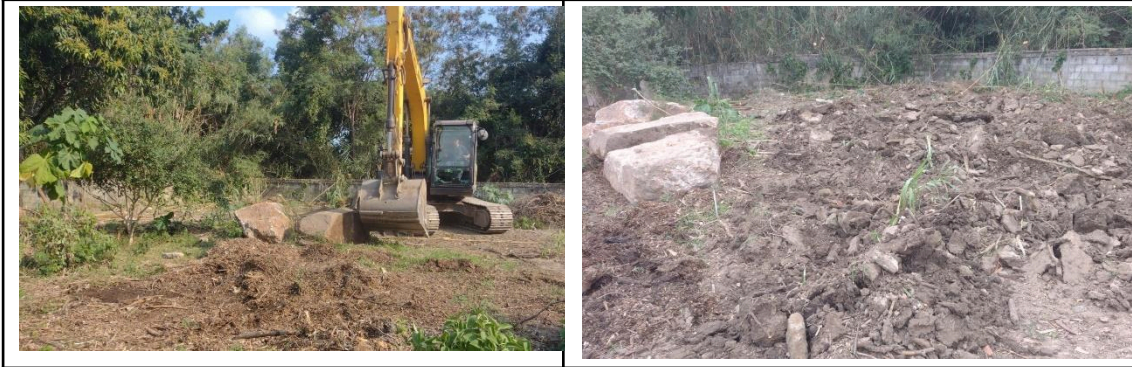
Figura 23- Preparação do terreno para receber a horta em mandala.
