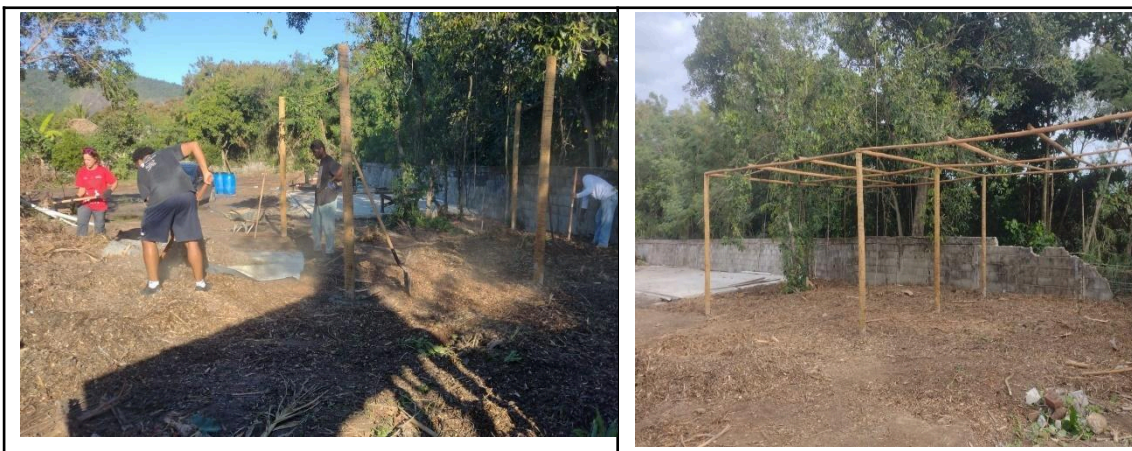
Figura 20- Pergolado. Nivelamento do terreno para receber a estrutura (esquerda). Área pronta para uso (direita). Entre 4 e 7/7/ 2025.
