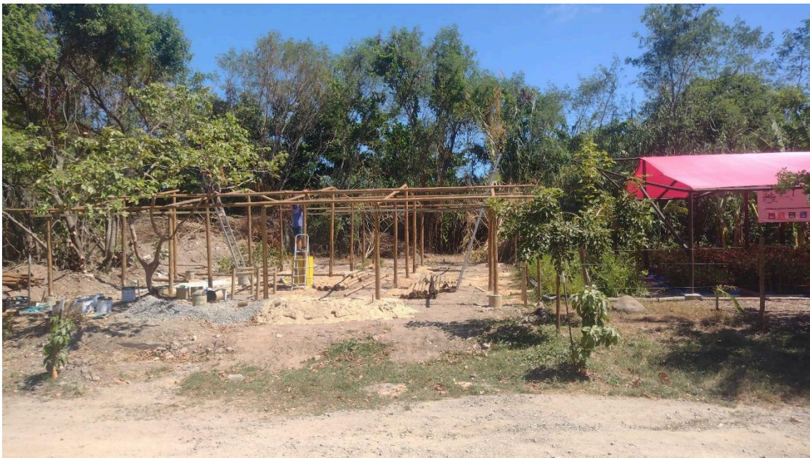
Foto 18 a, b – Construção do viveiro – Colocação das vigas em 01 de março de 2025
