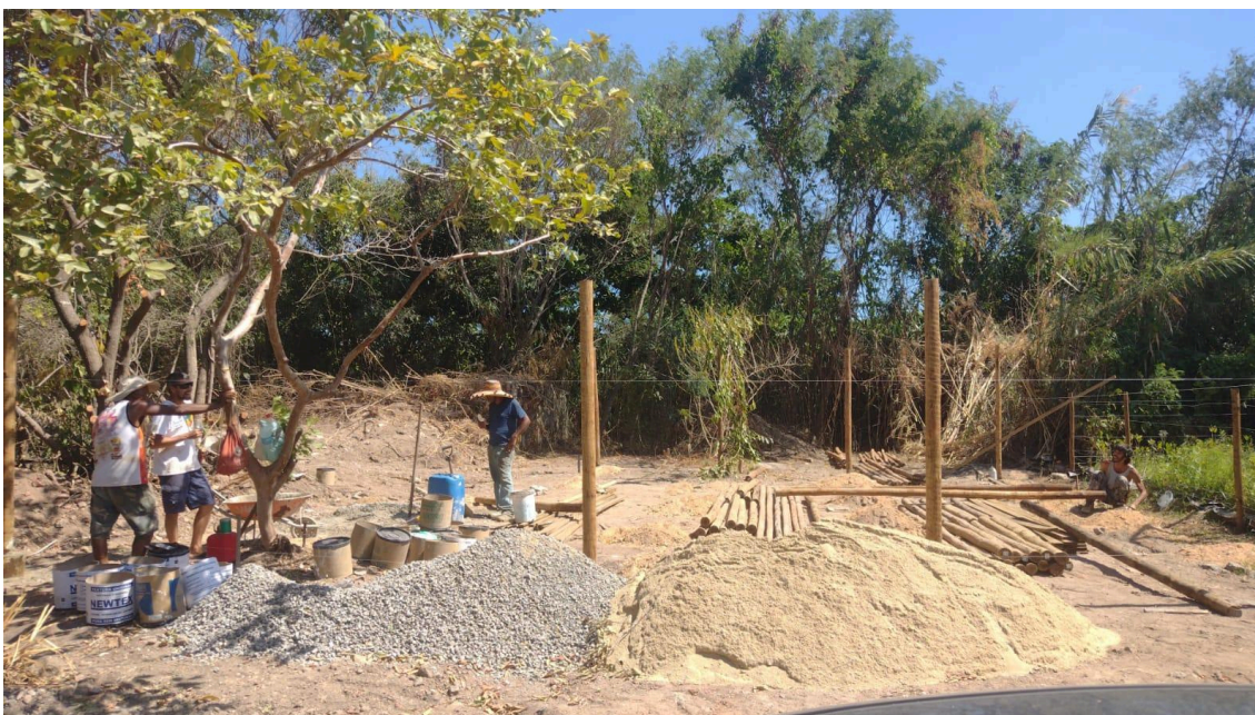
Foto 16 – Construção do viveiro – chegada de material para as sapatas em 24 de fevereiro de 2025.
