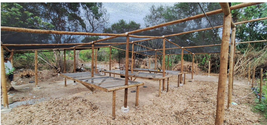
Foto 24 a, b – Construção do viveiro – Confeção das bancadas e colocação do sombrite em 19 de março de 2025.
