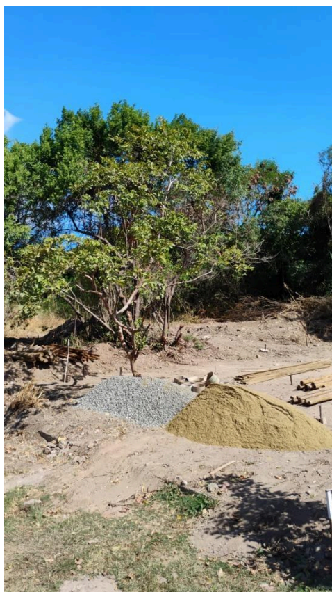
Foto 13 – Construção do viveiro – chegada de material para as sapatas em 24 de fevereiro de 2025
