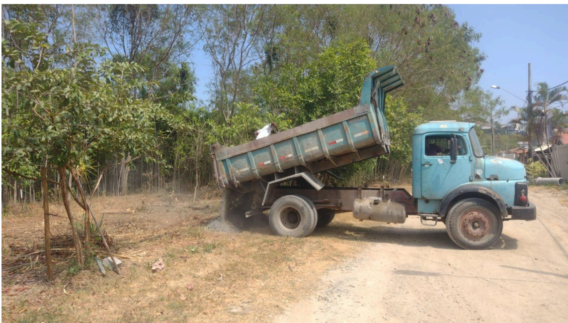
Foto 22 – Construção do viveiro – Material picado sendo recolocado em 11 de março de 2025.
