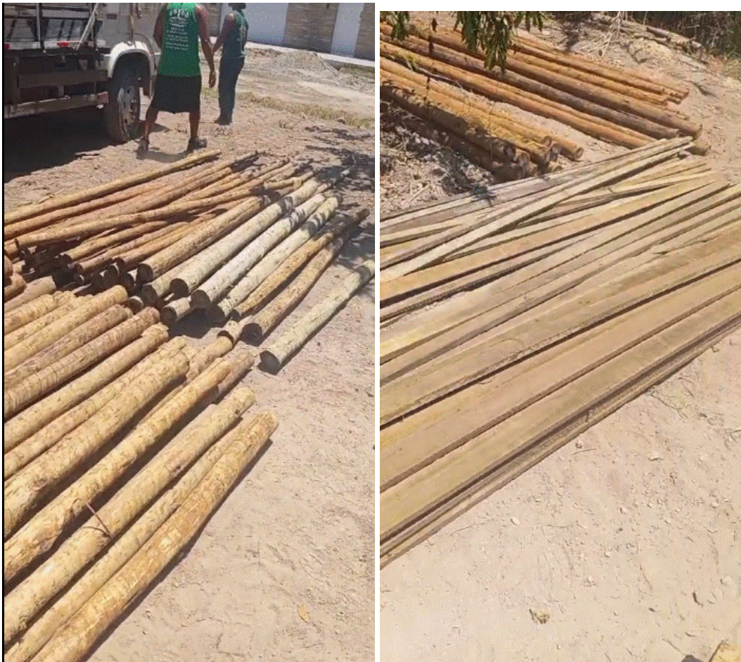
Foto 11 – Chegada das madeiras para construção do viveiro em 22 de fevereiro de 2025
