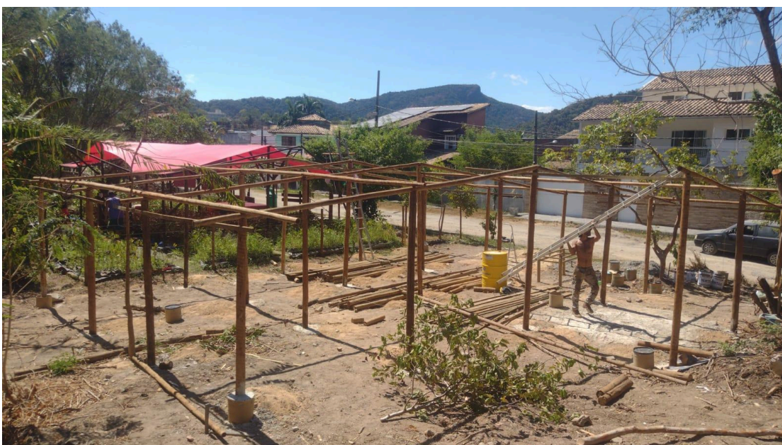
Foto 19 a,b – Construção do viveiro – Finalizando a colocação das vigas em 07 de março de 2025
