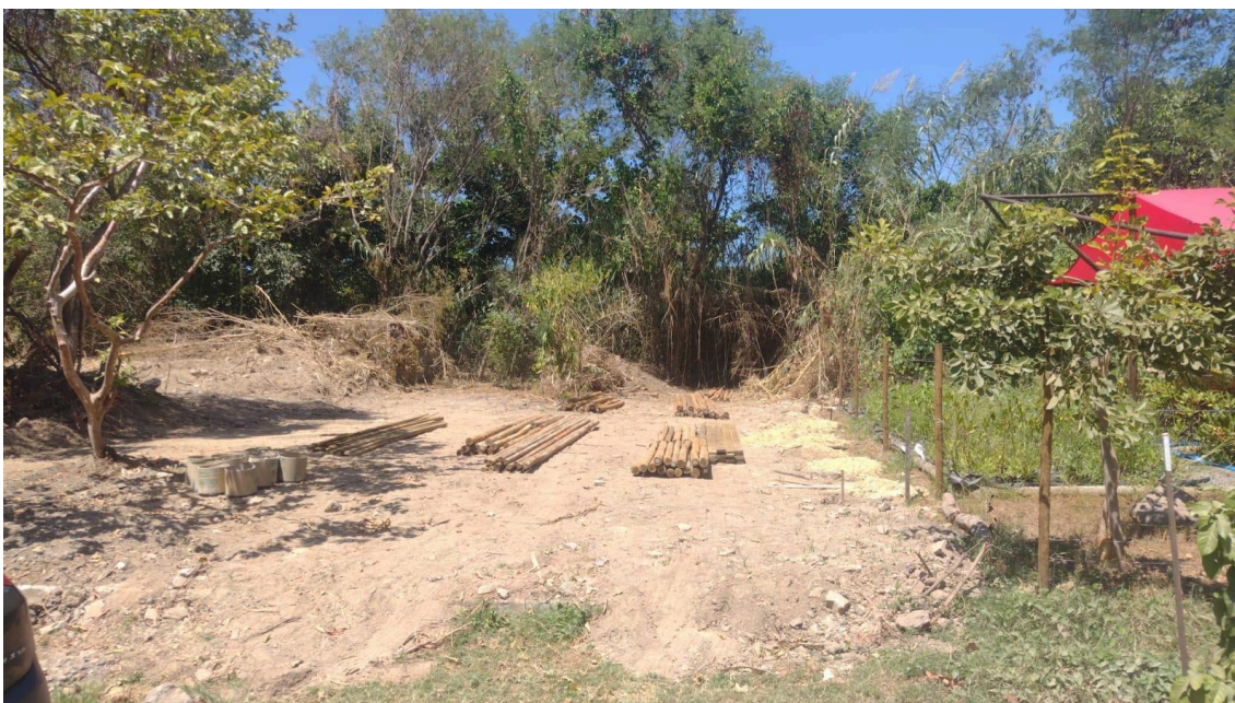
Foto 12 – Construção do viveiro em 24 de fevereiro de 2025
