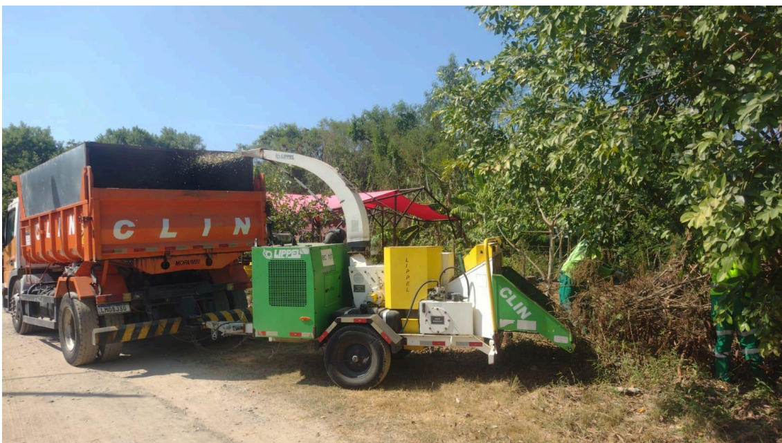
Foto 21 – Construção do viveiro – Picadeira em 11 de março de 2025.
