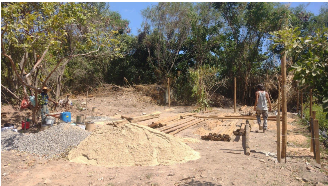
Foto 15 – Construção do viveiro – chegada de material para as sapatas em 24 de fevereiro de 2025
