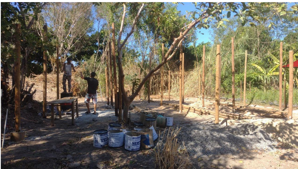
Foto 17 – Construção do viveiro – Fixação dos pilares em 27 de fevereiro de 2025.
