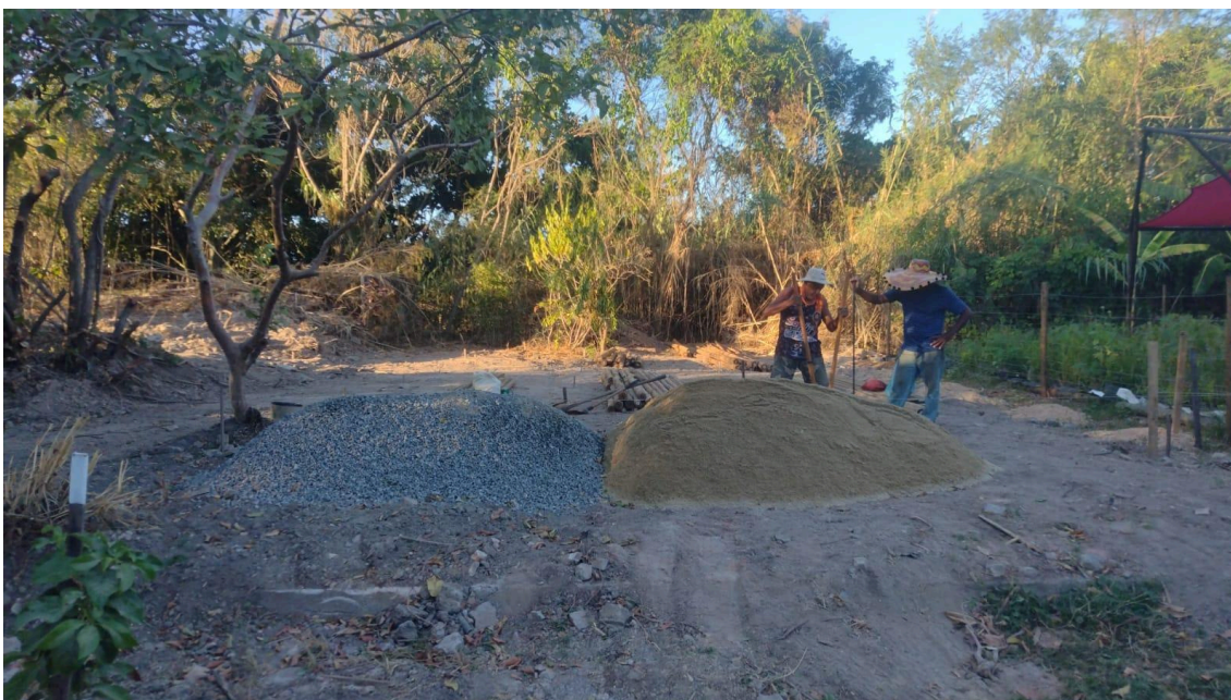
Foto 14 – Construção do viveiro – chegada de material para as sapatas em 24 de fevereiro de 2025
